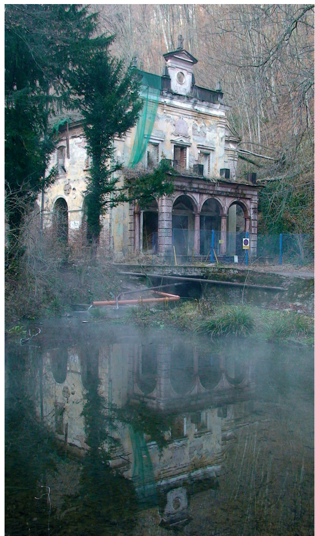
Foto 11.1. Fațada pavilionului nr. 1 de pe p. Băilor, menajată la demolarea acestuia.
