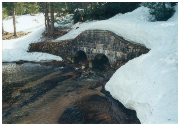
Foto 12.2. Izvorul Pescăriei în luna aprilie 2000, înainte de începerea lucrărilor de captare a sursei.
