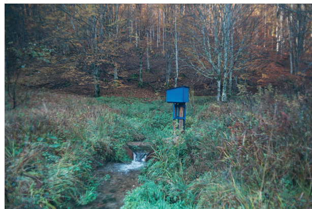
Foto 4.5. Secțiune hidrometrică cu deversor și limnigraf la Izburul Feredeou
